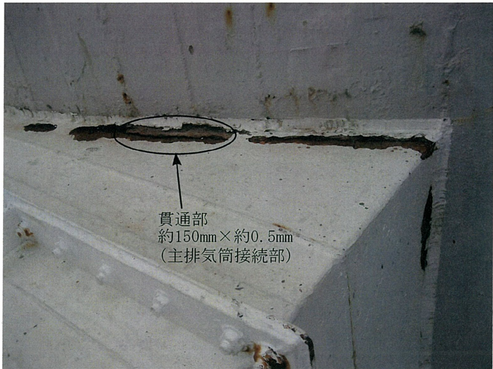
ダクト上面貫通部の状況
